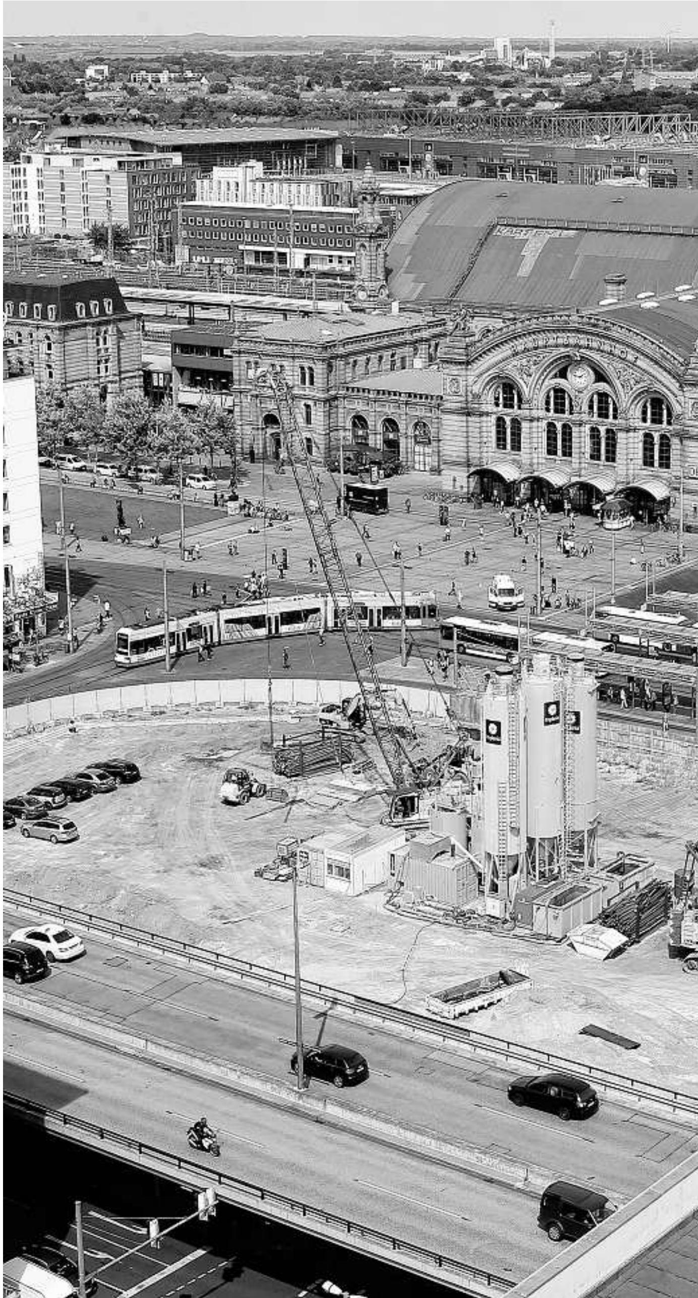
Mit dem ersten Spatenstich wurde die Großbaustelle vor dem Bremer Hauptbahnhof eröffnet, Anlass für viele Leserinnen und Leser, ihren Unmut über die Bebauung an dieser Stelle zu äußern. FOTO: FRANK THOMAS KOCH.
